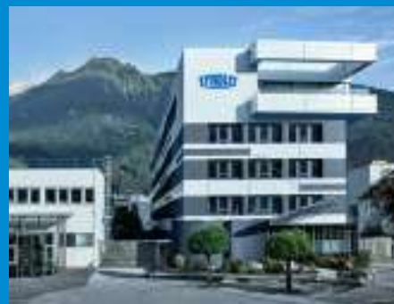
Sede central de TYROLIT en Schwaz (Austria)
