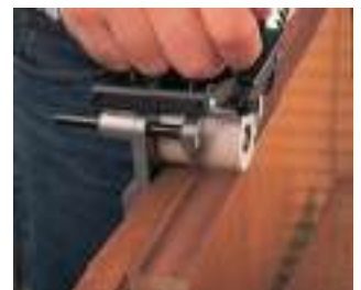
Aplacado de la cara superior del solape.
