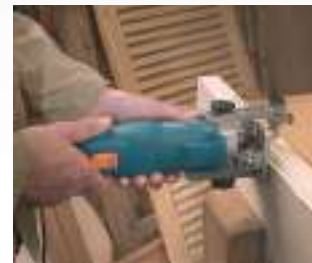
Realización de molduras.
