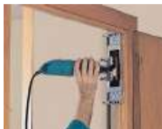
Colocación en el marco (Mod. A093)
