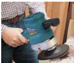
Trabajos de marmolistería.
