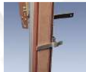
Fijación de los cercos a la plantilla.
