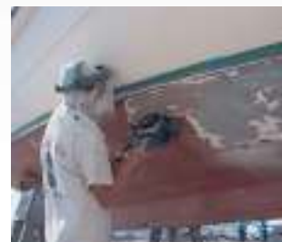
Trabajos de mantenimiento en astilleros.
