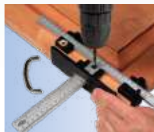
Taladrado para tiradores de puertas.
