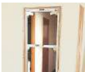
Colocación de la PB83E enrasada con el precerco.
