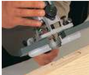
Colocación de pernios con el cabezal ZB93.
