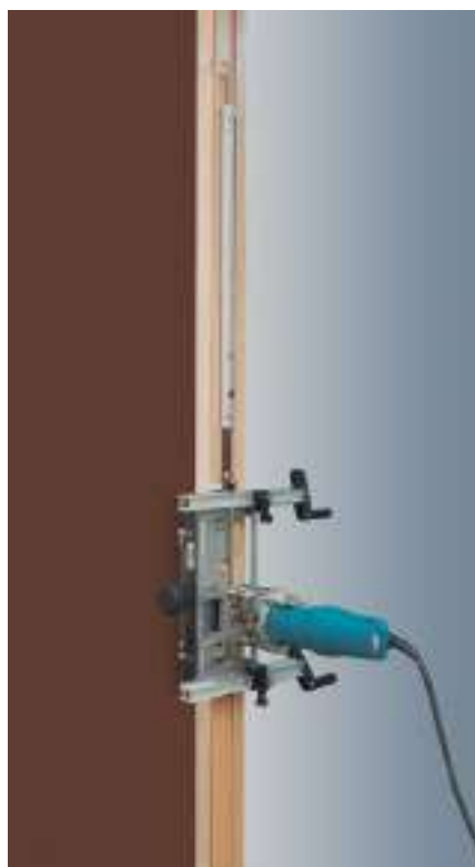
Realización del segundo encaje en el marco.
