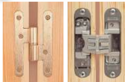
Acabados perfectos en la realización de encajes. Colocación de bisagras invisibles en una sola operación y sin cambiar la plantilla.
