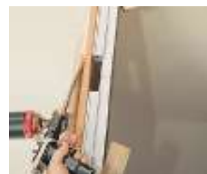
Rellenado con espuma de poliuretano.
