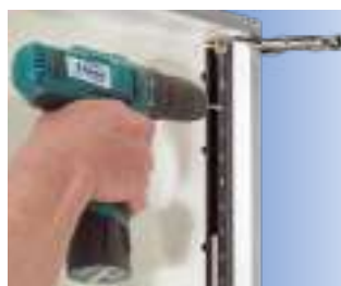
Taladrado para la colocación de estantes.
